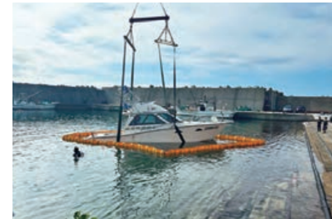
クレーンによる引き上げ
